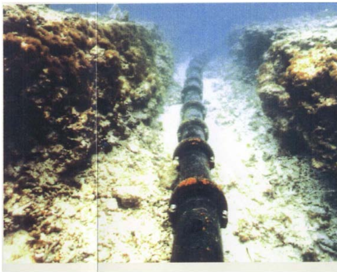
图 2.2-10 220kV 海缆登陆段保护套管
