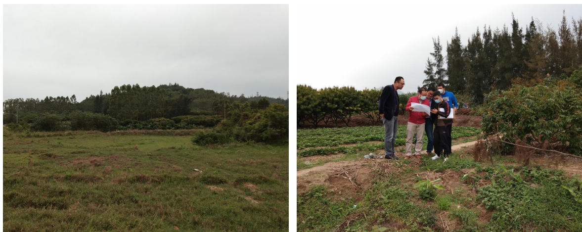
图 4-1 拟建站址现状照片
